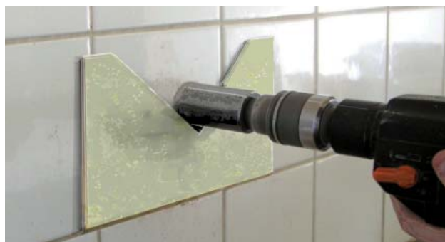
Ett utsågat V i en platta kan utgöra ett enkelt stöd.
