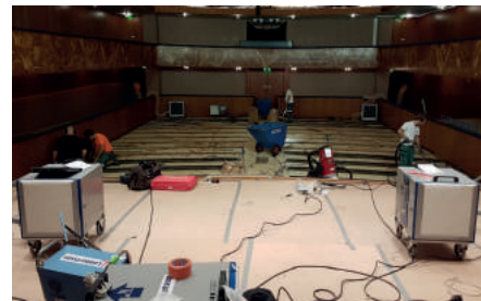
Totalrivning och ombyggnation Större lokaler & starka dofter
